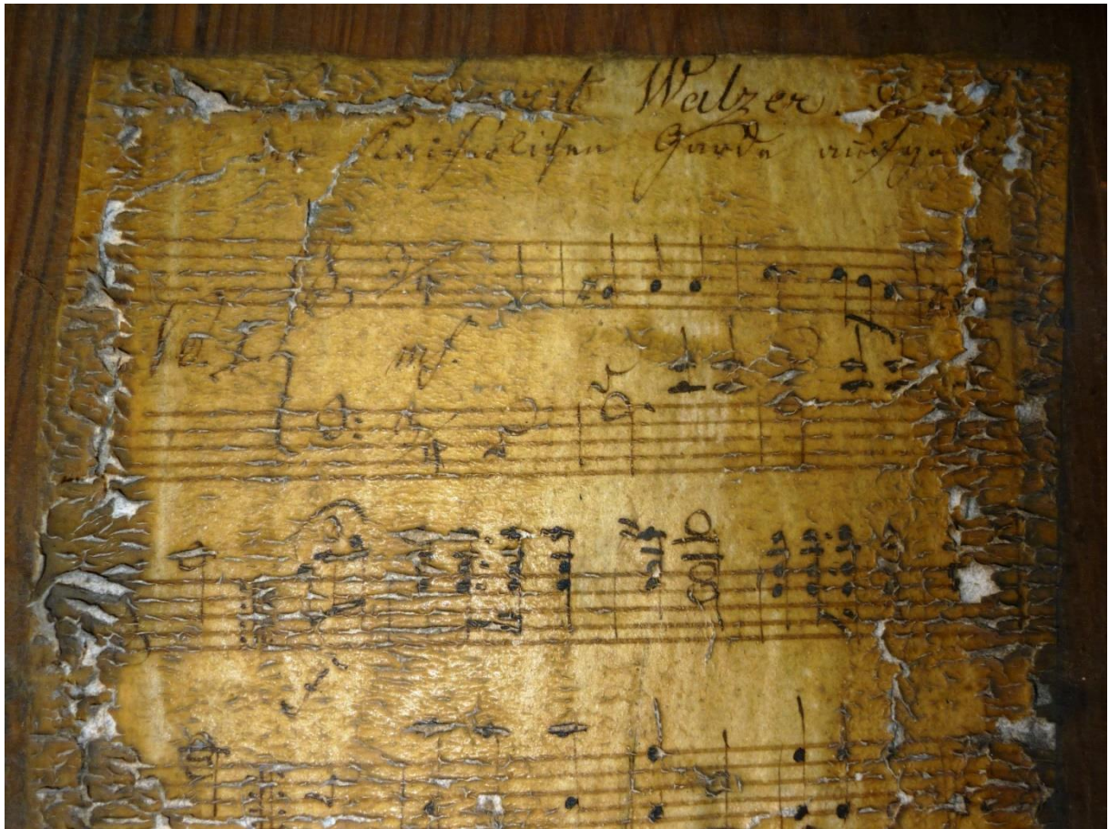
Abbildung 73: Im Orgelwerk der großen Orgel zur Abdichtung von Windkanalundichtigkeiten aufgeklebte Musikalien, Bild 1. Photo: Christian Scheffler.
