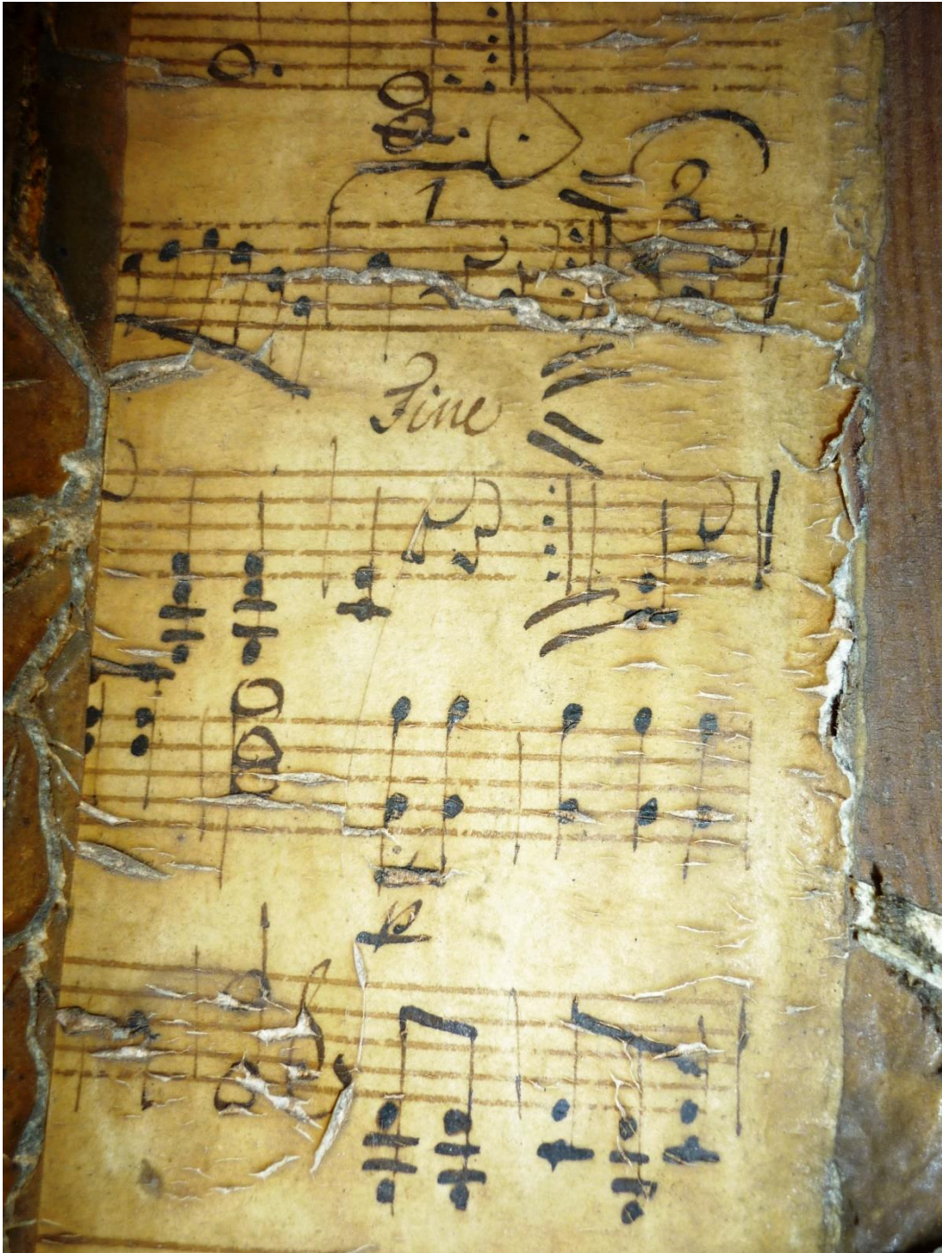
Abbildung 74: Im Orgelwerk der großen Orgel zur Abdichtung von Windkanalundichtigkeiten aufgeklebte Musikalien, Bild 2. Photo: Christian Scheffler.
