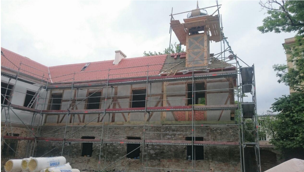
Abbildung 81: Das Archivgebäude während der Restaurierung 2015.
